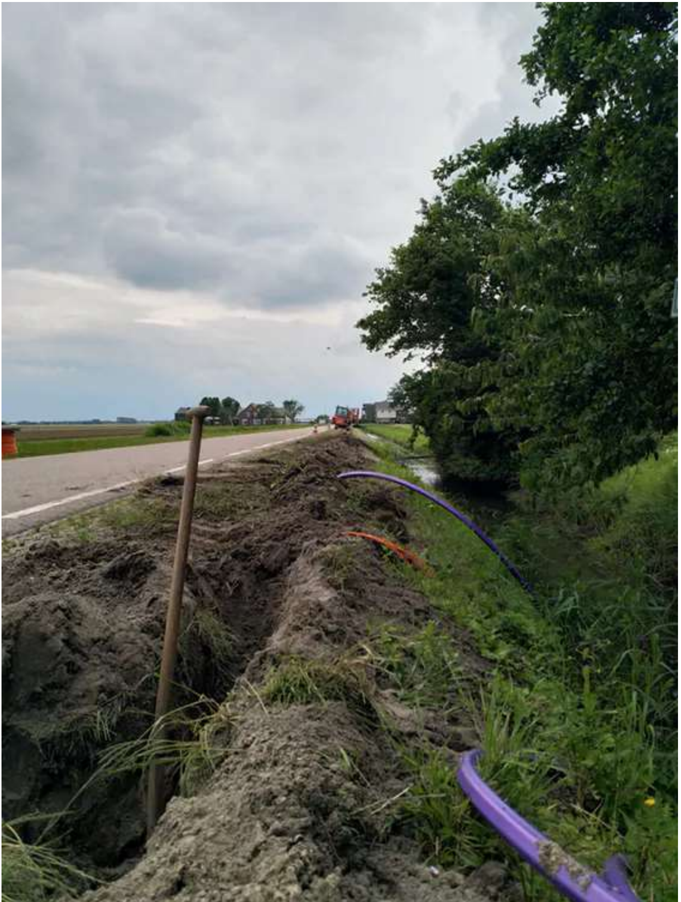
Aanleg van kabels, elders in Noord-Holland. Hier legde Kabeltex eveneens een paarse kabel. Later werd de berm weer opgemaakt voor een oranje kabel, in van in dit geval van FiberNH. Foto: Stijn van Gils
